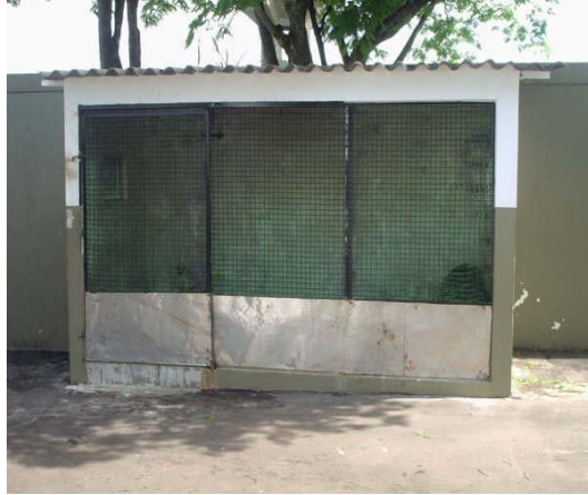
Figura 6. Local da Infraero para depósito de resíduos.
